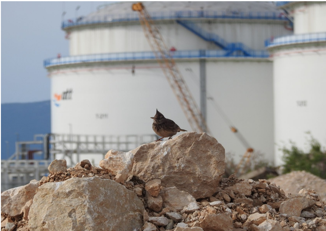
Fotografija 1. Gradilište na terminalu - dom za kukmaste ševe
